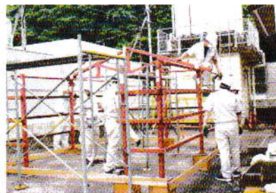
鉄骨小屋組立
