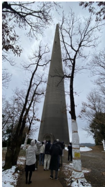
◆針尾無線塔（重要文化財） 旧日本海軍が建設した約100年前の鉄筋コンクリート製無線塔。高さ136mで、今もなお県内で最も高い建造物で、免震技術も施してある。太平洋戦争の開戦を告げた「ニイタカヤマノボレ1208」を送信した施設として有名。
